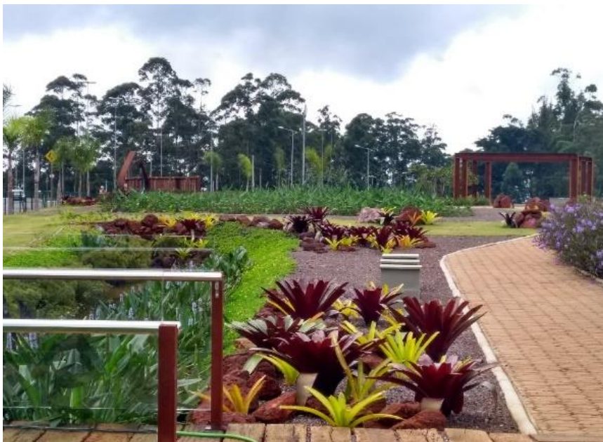
Figura 4: Wetlands para tratamento de esgoto sanitário na Mina de Águas Clara - Vale.
