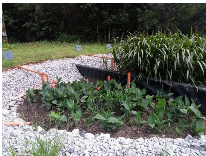
Figura 3: Wetlands para tratamento de lodo de reator UASB no SAAE Itabirito.
